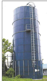
スチール製の真空サイロ
