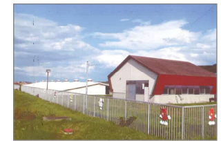
ファームポンド（奥）と揚水ポンプ機場（手前）
